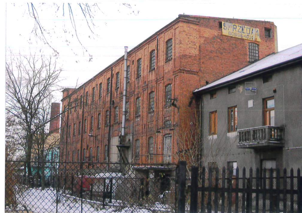
Fot. 4. . Widok od ul. Garbarskiej, od prawej budynki: K, I, G, sprzed remontu bud. K, fot. MPU [www.mpu.radom.pl/opracowania1/architektura-radomia/garbarnia-przy-ul-garbarskiej-27
