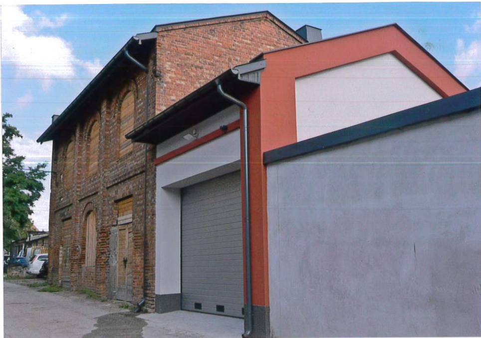
Fot. 10. Kotłownia [A] , widok na elewację południową, fot. WUOZ del. Radom, 2020.
