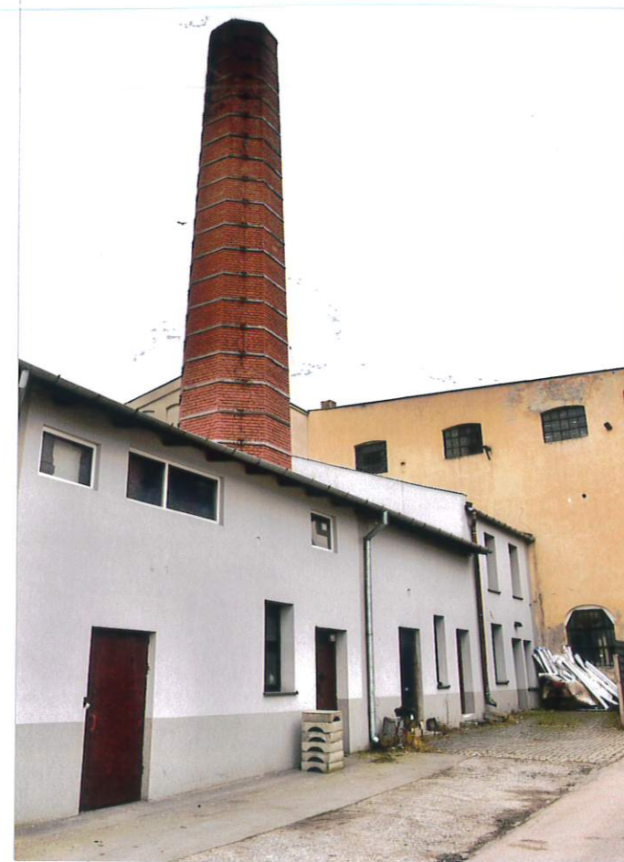
Fot. 9. Tylna część podwórza, budynki E, F i komin [B], fot. WUOZ Del. Radom, 2020.
