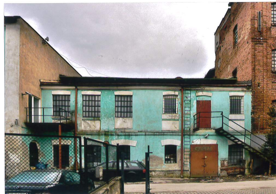
Fot. 6. Budynek I piętrowy [G], stan przed remontem, fot. WUOZ del. Radom, 2020.
